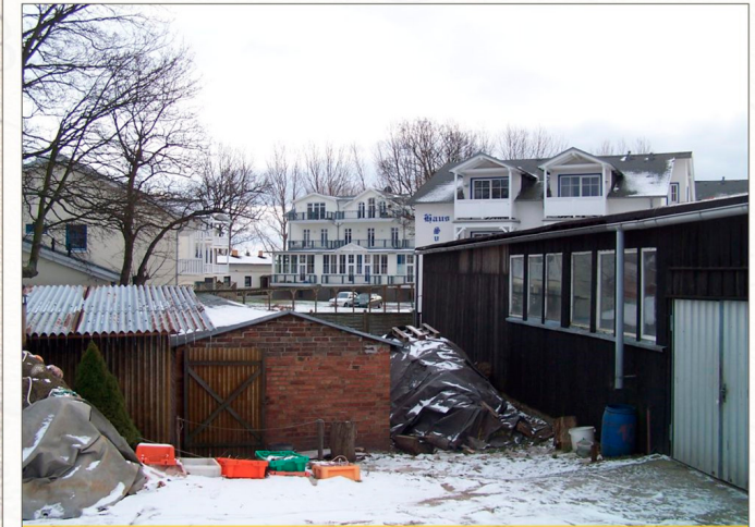
Alte Standort der Fischer mit Räucherei und Salzhaus bis 2010 (Abriss)
